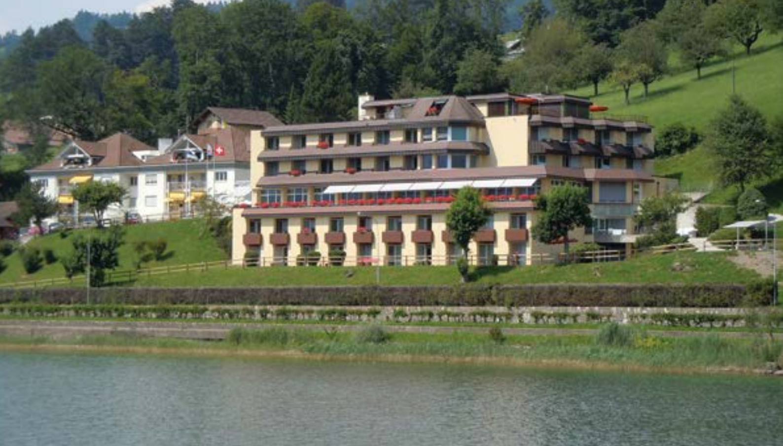
Pflegeheim «Zentrum Breiten», Oberägeri
